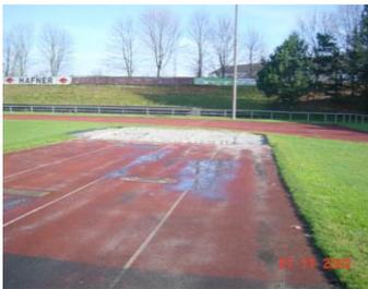
Diese Bilder zeigen deutlich, dass hier Handlungsbedarf besteht. Die Stolperkanten, Löcher und sonstigen Beschädigungen sind für die Wettkämpfer und auch für die trainierenden Leichtathleten eine große Gefahr. Darüber hinaus ist das Aufschieben der nötigen Reparaturen später oft mit einem kostspieligeren Aufwand verbunden.
